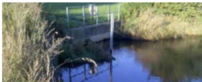
Udløb for rensset spildevand til Horsens Fjord
